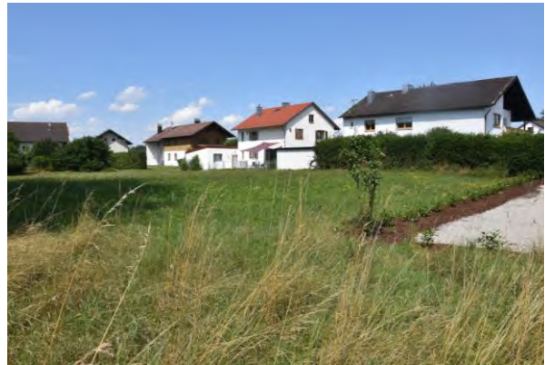
Blick nach Nordosten auf die benachbarte Wohnbebauung entlang der Saliterstraße und den Parkplatz des Anna Hospizvereins.
